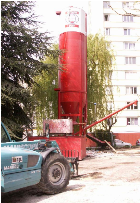
Le ciment est stocké dans un silo en bas du parking (1 camion par jour).
